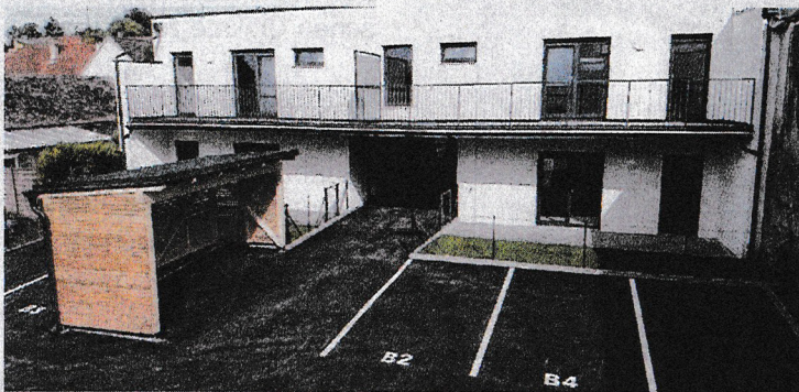
Die Wohnungen wurden in Ziegelmassivbauweise mit Bramac Dachdeckung oder Flachdach errichtet.
